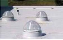
Une seule pièce sans raccord ni soudure. Hauteurs selon l'épaisseur d'étanchéité pour respecter le DTU 43
