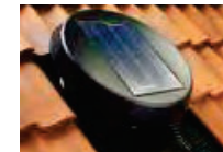
Installation sur tuiles
