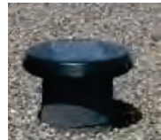
Installation sur toit terrasse
