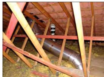
Un support structurel supplémentaire peut être nécessaire pour les longs passages horizontaux de tube.
