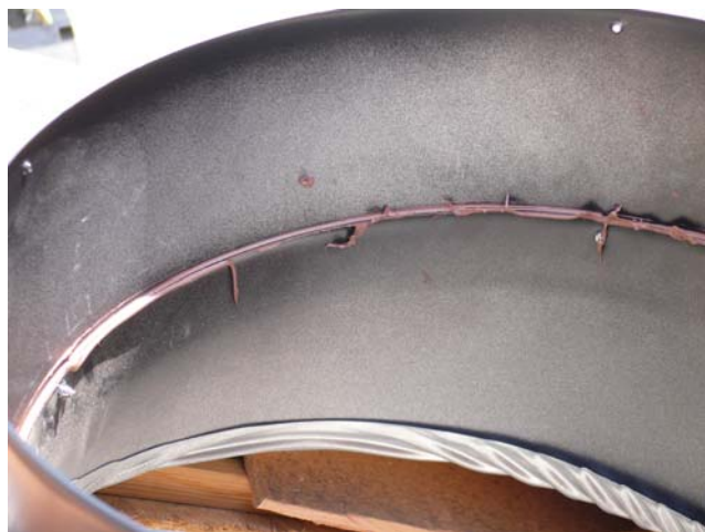
Vue intérieure du solin avec une rehausse
