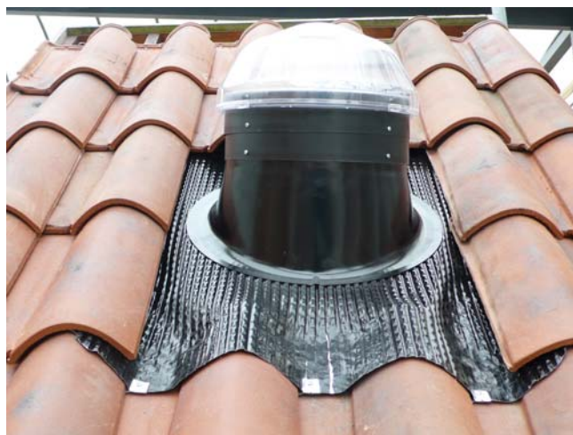
Exemple d'une installation avec 2 rehausse.
